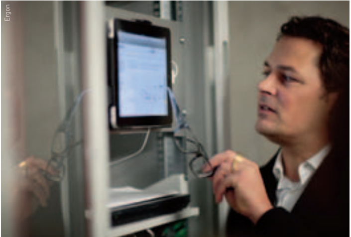
Über das lokale Netzwerk können die Daten ausgelesen werden, unabhängig von einer zentralen Steuerung.
