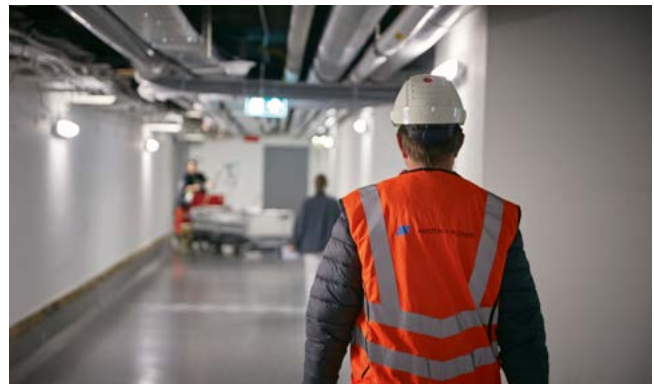
_DER TUNNEL: TROTZ GROSSBAUSTELLE GEHT DER SPITAL- BETRIEB WEITER.
